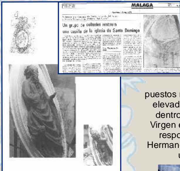
Restauración de la capilla del Cristo del Perdón
