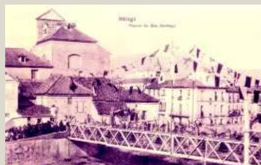
El «Puente de los Alemanes» engalanado para su inauguración
